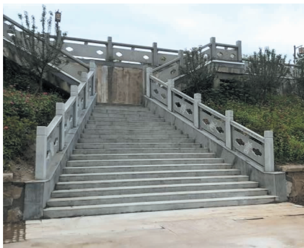
2022年6月,拓展改造后的两侧石阶楼梯 (提供:袁林)
