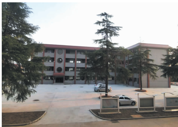
2022年,斗姆湖中学小学部教学楼建设项目
