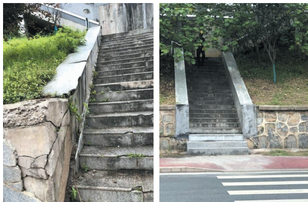
2022年6月,滨江大道防洪大堤斜坡面残破面修复前后对比图 (提供:袁林)
