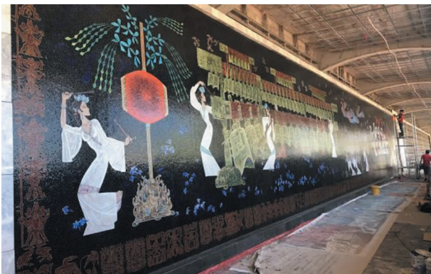
壁画《楚乐》安装现场
