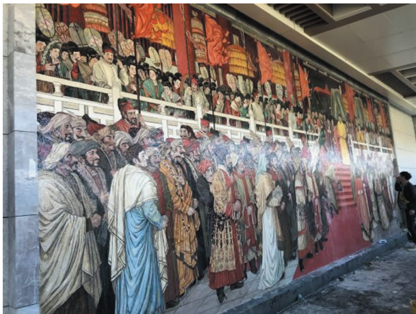
壁画《贞观盛会》安装现场 (提供:姜丹)
