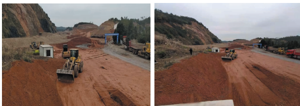
CK03 矿坑治理完工 CK03 矿坑治理现状 (提供:郭杰)
