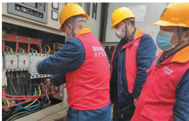
2020 年,国家电网常德供电公司工作人员抢修电路
