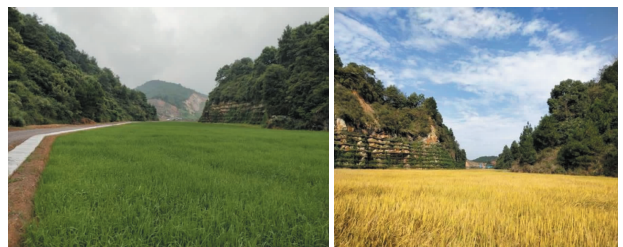
CK05 矿坑采坑及边坡治理后 (提供:郭杰)
